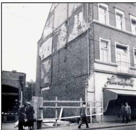
Oben: Der linke Trakt des seit dem Neubau 1897 aus drei Achsen bestehenden Restaurants und Wohnhauses hatte schwere Bombenschäden erlitten und war bis 1958 immer noch nicht wieder aufgebaut worden. Das ergibt sich aus der Tatsache, das im mittleren Teil bereits das Fleischerfachgeschäft „Schweiserfurth“ mit entsprechendem Schaufenster eingerichtet war, dem der Gastronomiebetrieb hatte weichen müssen.
