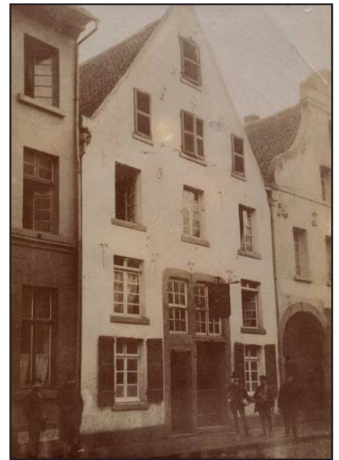
Eine Aufnahme des Hauses „Zum Bunten Ochsen“ aus dem Jahr 1896. Deutlich erkennbar im Nachbarhaus die Toreinfahrt, die zum „Bunten Ochsen“ gehört, aber durch die 1. Etage des Hauses Walge überbaut wurde.
